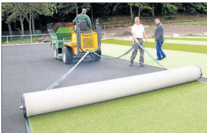
So machen das die Profis: In 65 Meter langen und drei Meter breiten Bahnen wird der Kunstrasen aus dem Platz ausgerollt.
